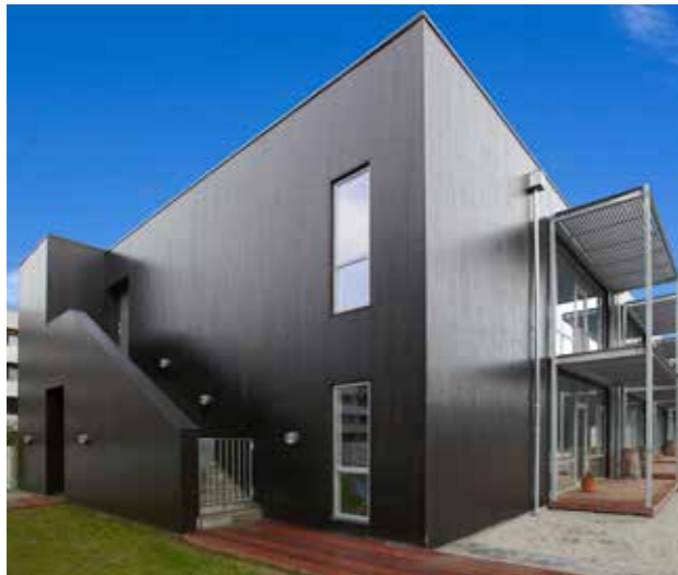
Branntrygt tre, fasade og inngangsparti.
