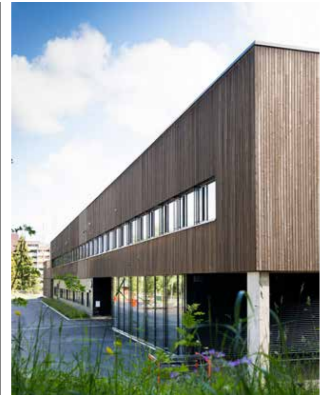
Fasadekledning i branntrygt tre.
