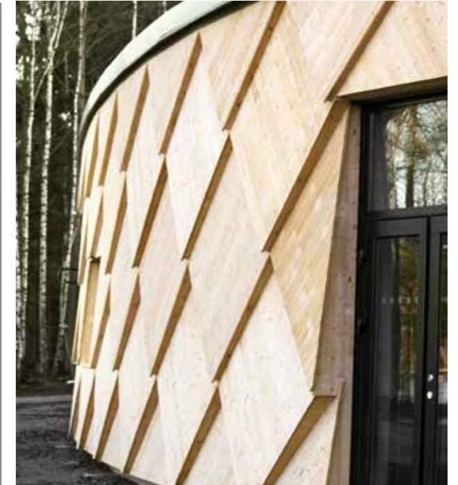
Hus med Organowood fasade
