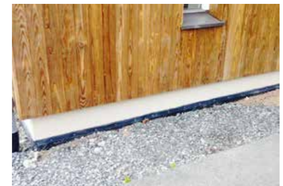
Kledning montert med 20 cm avstand til mark. Resultatet er perfekt.
